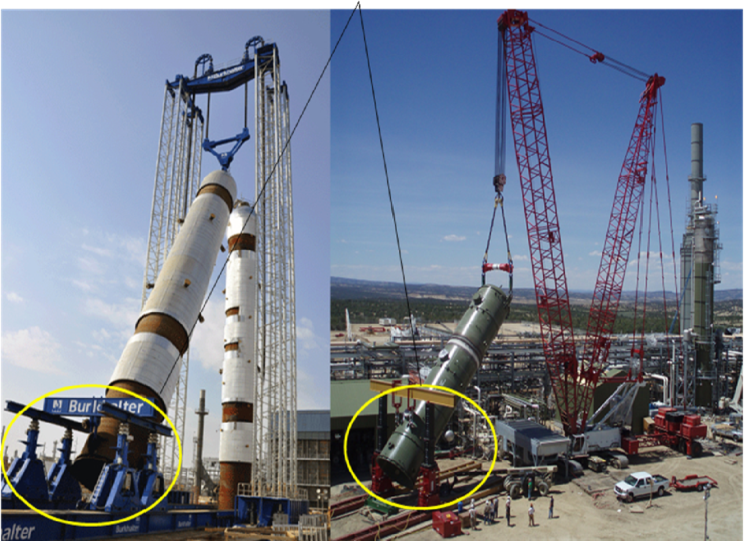
大型设备装运时的吊装
